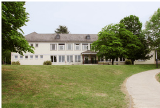
Unsere Schule liegt direkt auf dem Gelände des Haus auf dem Wehrborns.
